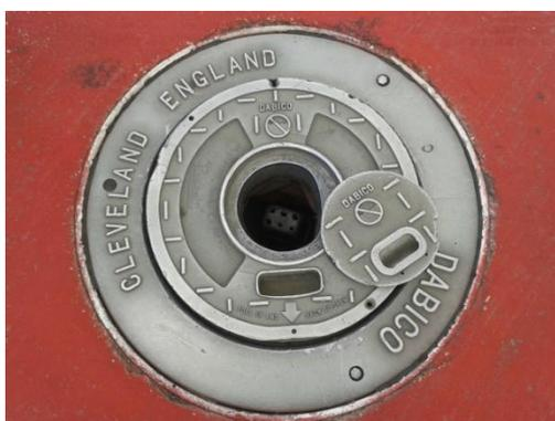
Figura 1 - Pozzetto 400 Hz
