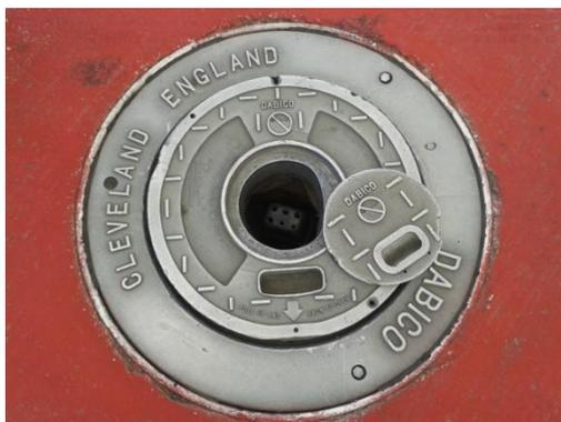
Figura 5 - Pozzetto 400 Hz
