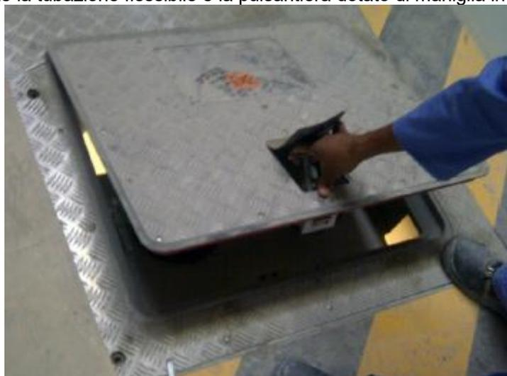
3. Pulsantiera fissa posta sul coperchio del pozzetto, dalla quale è possibile comandare il funzionamento dell'impianto. E' dotata dei seguenti comandi:
