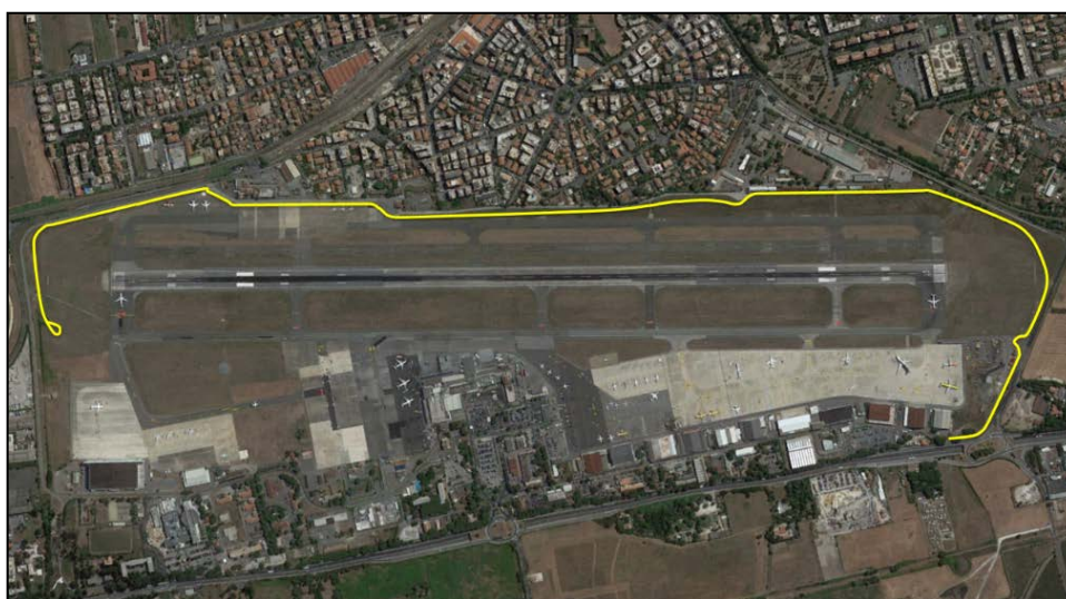
Ciampino, strada perimetrale
