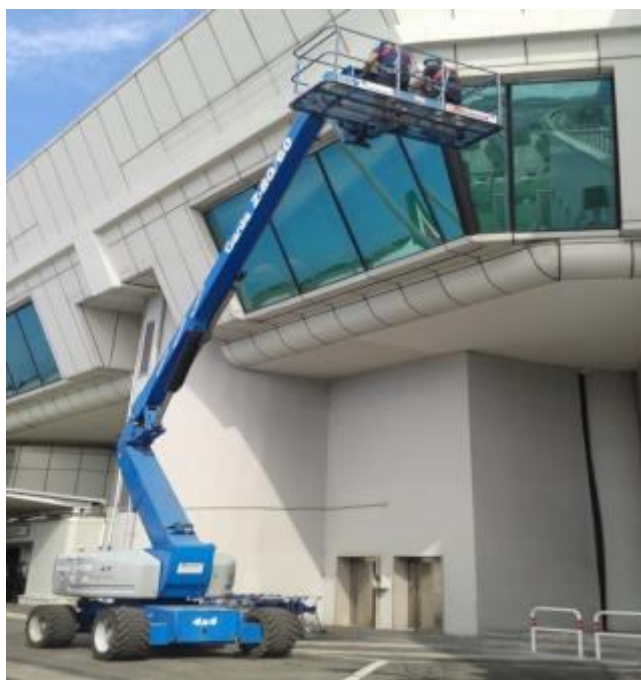
LAVORAZIONE IN CORSO
