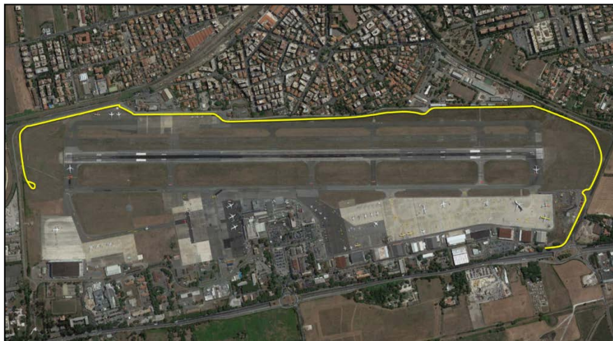
Ciampino, strada perimetrale
