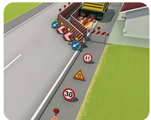
Figura 9 - Segnaletica provvisoria di cantiere
