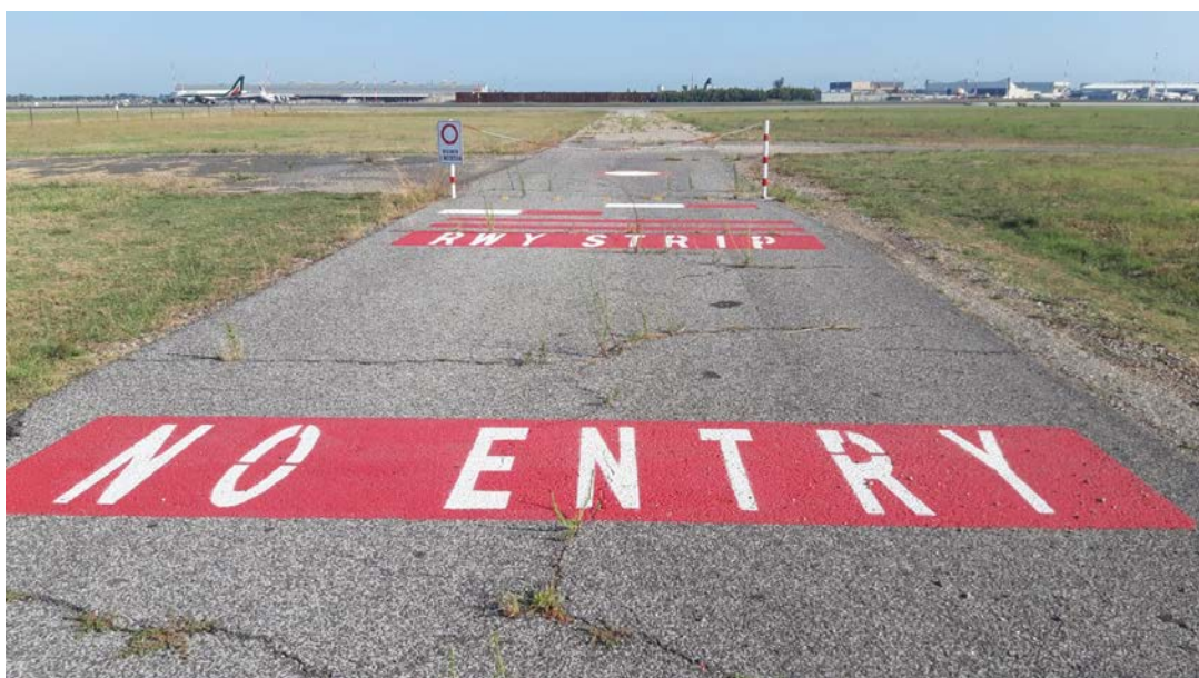
Figura 16- Segnaletica di ingresso in pista delle strade sulla perimetrale di Fiumicino
