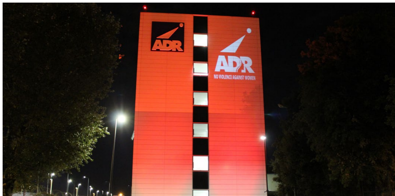
Palazzina direzionale Aeroporti di Roma
