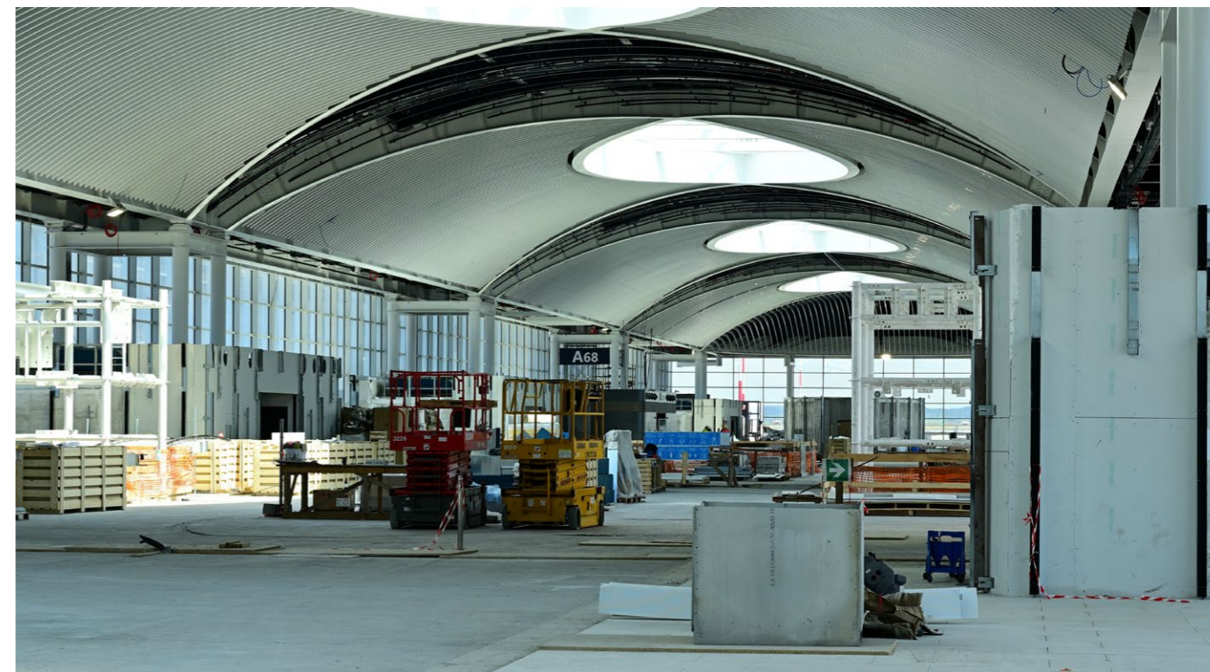
Il cantiere della futura Area d'imbarco A
